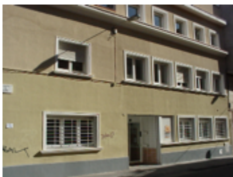
Edifici seu del Centre Ocupacional Esclat 2
